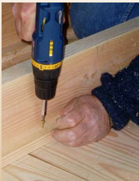
T-balkarna skruvas fast.
