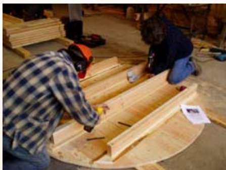
T-balkarna skruvas fast.
